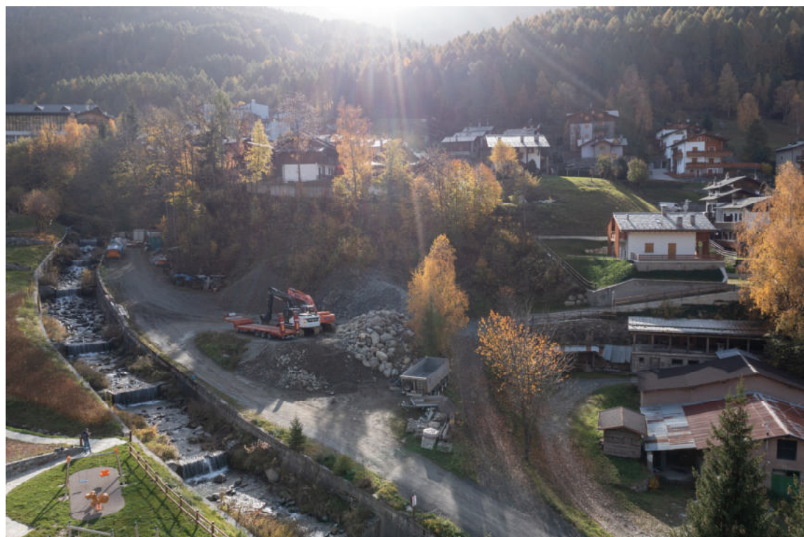
Figura 4-3– Vista dell’area interessata dal SUAP da nord.
